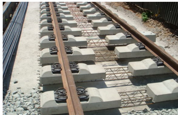
Εικόνα 1.4: Επιδομή από πυριτικά αδρανή, στρωτήρες από σκυρόδεμα, συνεχείς συγκολλημένες σιδηροτροχιές, ελαστικοί σύνδεσμοι. Στη Δυτ. Μακεδονία το δίκτυο είναι ήδη αναβαθμισμένο.
