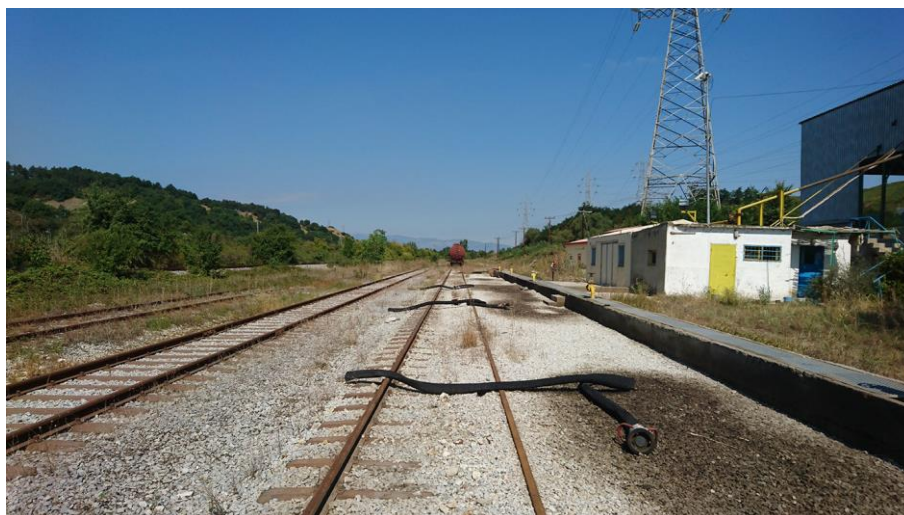
Εικόνα 5.4: Σιδηροδρομικός Σταθμός Υγρών Καυσίμων λιγνιτωρυχείων. Διακρίνονται οι ελαστικοί σωλήνες απομάστευσης και δεξιά το αντλιοστάσιο τροφοδοσίας της νέας δεξαμενής Diesel.
