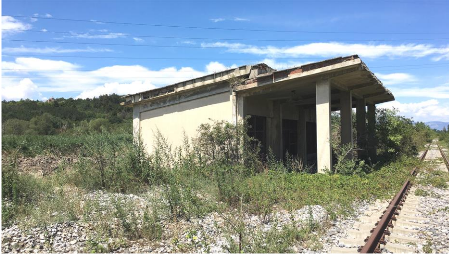
Εικόνα 2.3: Επιβατικός Σταθμός Αζώτου. Χρησιμοποιήθηκε στο παρελθόν για τις μετακινήσεις των εργαζόμενων προς τα λιγνιτωρυχεία και τους παλαιούς ΑΗΣ ΛΙΠΤΟΛ και Πτολεμαΐδας.
