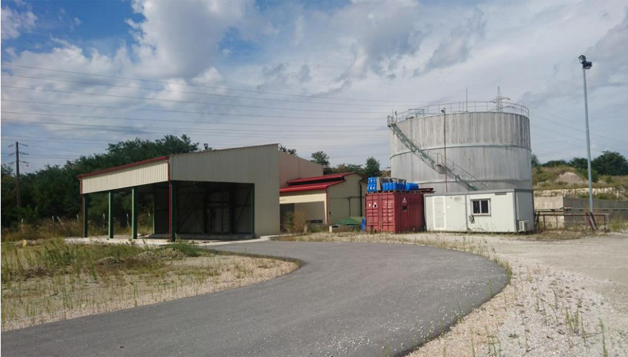
Εικόνα 5.5: Η νέα δεξαμενή Diesel Κίνησης 3.000 m 3 των λιγνιτωρυχείων, με σιδηροδρομική τροφοδοσία.
