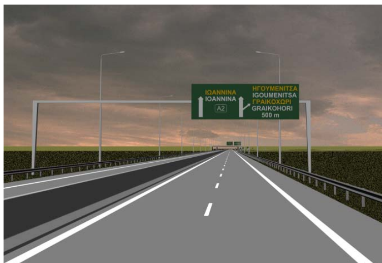
Εικόνα 3.9: Γέφυρα σήμανσης σε κόμβο. Τα βέλη αντιστοιχούν σε κάθε λωρίδα του αυτοκινητοδρόμου.
