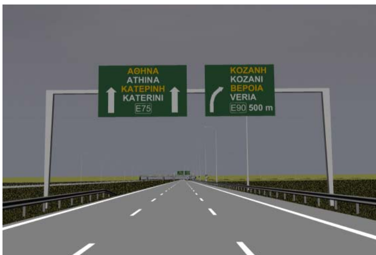
Εικόνα 3.11: Γέφυρα σήμανσης, το βασικότερο στοιχείο της σήμανσης ενός κόμβου. Ο συγκεκριμένος τύπος (Π-84) προειδοποιεί για απόσπαση της δεξιάς λωρίδας.
