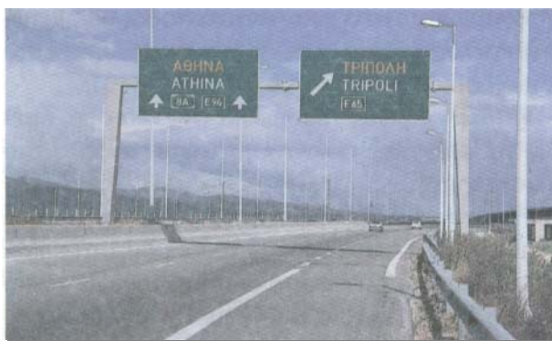
Εικόνα 3.8: Γέφυρα σήμανσης σε αυτοκινητόδρομο.
