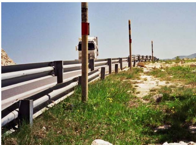
Km 22: Ένα από τα λίγα στηθαία επαρκούς ύψους, σε ένα πρόσφατα αναβαθμισμένο τμήμα. Διακρίνονται και τα παλιά στηθαία, ως μέτρο σύγκρισης. . .
