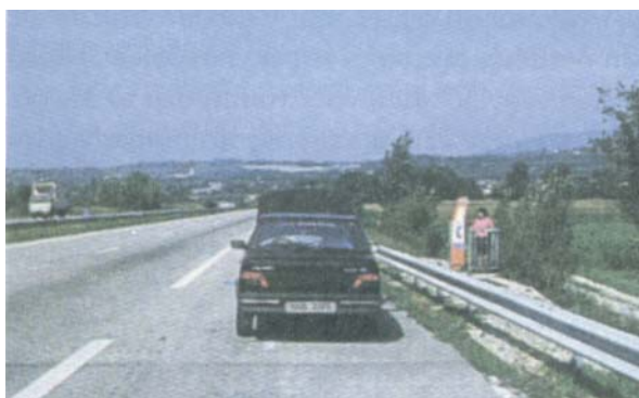
Εικόνα 10.5: Τηλεφωνικός θάλαμος ανάγκης σε αυτοκινητόδρομο.
