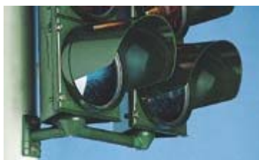
Εικόνα 5.7: Στερέωση με βραχίονα με επέκταση.
