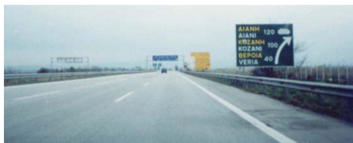
Εικόνα 11.2: ...Αμέσως μετά ακολουθεί η πινακίδα που φαίνεται σε πρώτο πλάνο, και η οποία αποτελεί την πρώτη κατά σειρά προειδοποιητική κατευθύνσεων. Ακολουθεί πινακίδα ενημέρωσης έργων του ΠΑΘΕ, διακρίνεται μία καφέ πινακίδα τουριστικού ενδιαφέροντος προς Βεργίνα, ενώ η κυανή γέφυρα σήμανσης στο βάθος ενημερώνει ξανά για την έναρξη των έργων...
