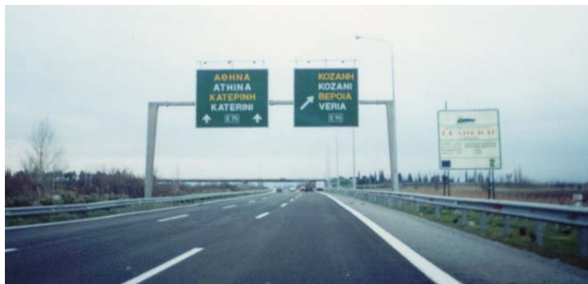
Εικόνα 11.4: ...Προ της εξόδου έχει τοποθετηθεί μία γέφυρα σήμανσης τύπου Π-85, ενώ μπροστά της βρίσκεται πινακίδα του ευρωπαϊκού προγράμματος “LEADER II”.
