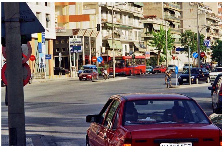
Εικόνα 11.17: Η Εικόνα είναι ηλεκτρονικά επεξεργασμένη και δείχνει πώς με την προσθήκη μερικών τυπικών πινακίδων καθοδήγησης και απαγόρευσης εισόδου, η εικόνα του κόμβου βελτιώνεται σαφώς. Ειδικά η έλλειψη σημάτων στην αιχμή της διαχωριστικής νησίδας της οδού Παπαναστασίου (ακριβώς απέναντι) είναι επιεικώς απαράδεκτη.
