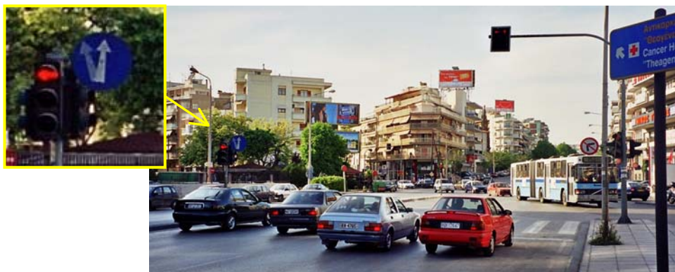
Εικόνα 11.19: Ασυμφωνία μεταξύ σήμανσης και σηματοδότησης, που επιπλέον για να επιτευχθεί, κάποιος θα πρέπει να εξάσκησαν... και τις χειροτεχνικές τους δεξιότητες...
