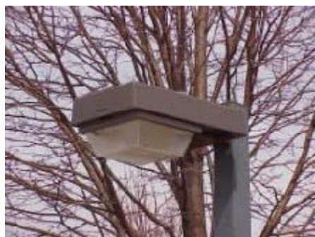
Εικόνα 7.6: Φωτιστικό σώμα χώρου στάθμευσης.
