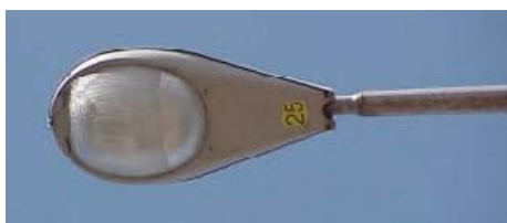
Εικόνα 7.2: Φωτιστικό σώμα οριζόντιας διάταξης.
