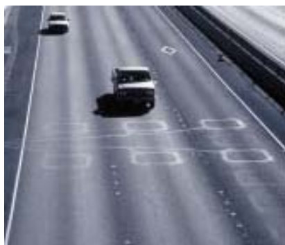
Εικόνα 9.1: Ζεύγη μαγνητικών ανιχνευτών βρόχου.
