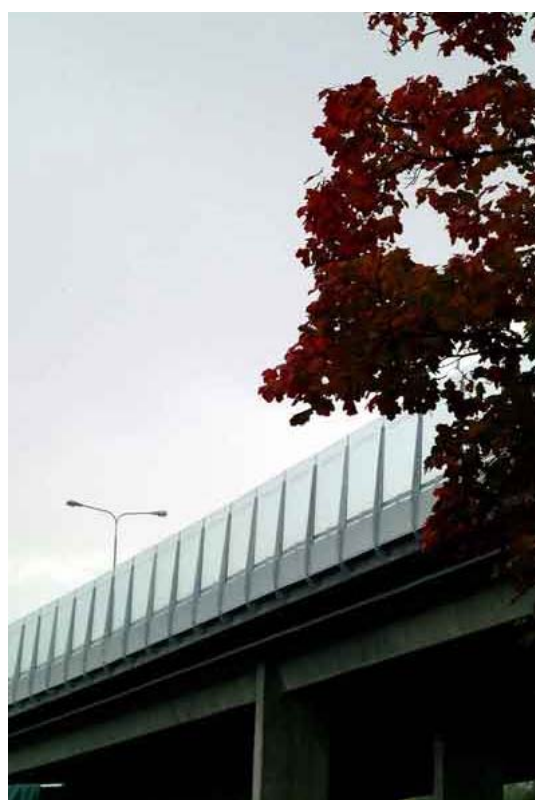
Εικόνα 8.6: Διαφανές ηχοπέτασμα επάνω σε γέφυρα.
