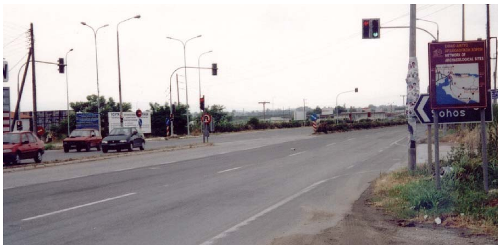
Εικόνα 11.10: Άποψη του κόμβου όπου διακρίνονται οι διάφορες πινακίδες καθοδήγησης και οι σηματοδότες.
