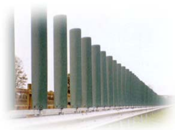
Εικόνα 10.1: Αντιθαμβωτικό πέτασμα από κατακόρυφους στύλους.
