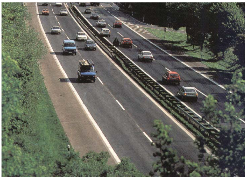
Εικόνα 1.3: Ενισχυμένο αμφίπλευρο στηθαίο σε ενδιάμεσο χώρο αυτοκινητοδρόμου.
