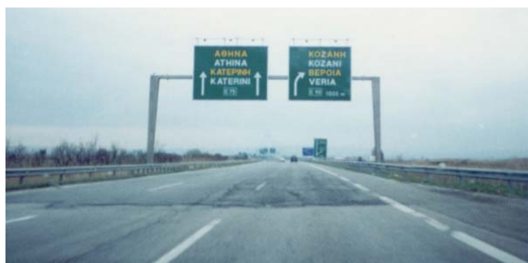
Εικόνα 11.3: ...Σε απόσταση 1000 m πριν από τον κόμβο, το πρώτο κλασικό σήμα κατευθύνσεων σε γέφυρα τύπου Π-84. Ακολουθεί παράπλευρη πινακίδα κατευθύνσεων Π-81. Η ίδια ακριβώς διάταξη του ζεύγους επαναλαμβάνεται άλλη μία φορά, ενώ εμβόλιμα βρίσκεται άλλη μία πινακίδα ενημέρωσης έργων...
