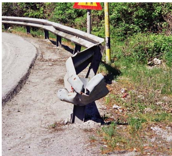
Km 19: Άλλο ένα μεγάλο πρόβλημα των μεταλλικών στηθαίων στην ορεινή διάβαση Καστανιάς είναι η συστηματική αποφυγή της κατάλληλης διαμόρφωσης των αιχμών. Η πρόσπτωση ενός οχήματος αξονικά επάνω στην αιχμή μπορεί να έχει πολύ σοβαρές συνέπειες.
