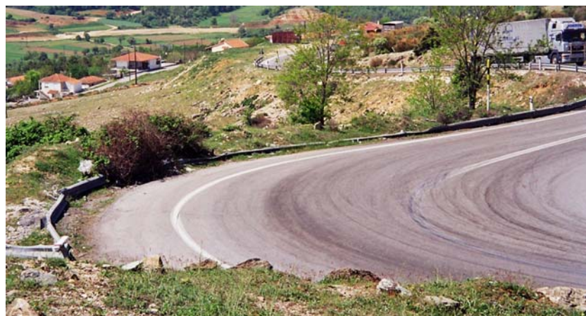
Km 31: Η πρώτη χαρακτηριστική «φουρκέτα» μετά τον Πολύμυλο. Τα σημάδια στο οδόστρωμα προδίδουν τις δυσκολίες που καλούνται να αντιμετωπίσουν τα ελαστικά των οχημάτων, η δε κατάσταση των στηθαίων ότι κάποια από αυτά δεν αντεπεξήλθαν. Αν, μάλιστα, τα στηθαία δεν αποκατασταθούν τα ταχύτερο, κάποιοι οδηγοί ίσως ζήσουν δυσάρεστες εμπειρίες.
