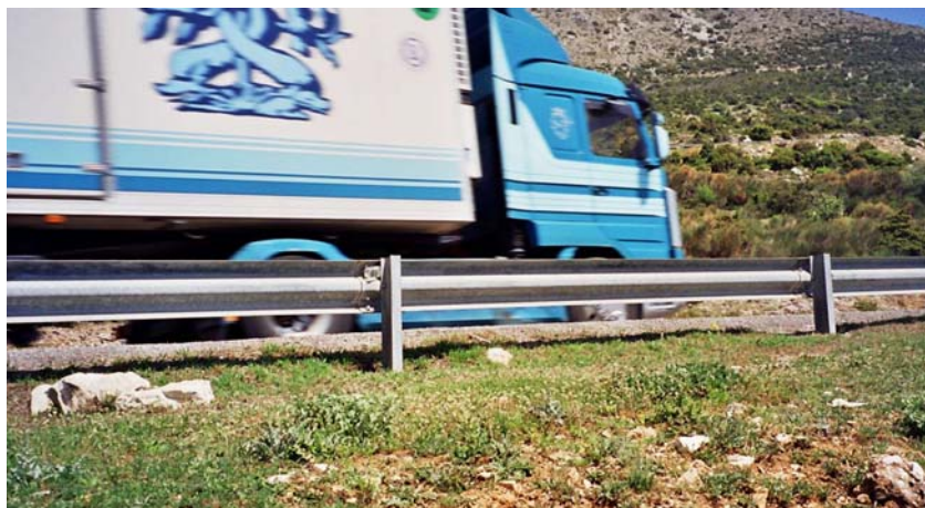
Km 31: Στηθαίο ύψους όχι παραπάνω από 45 cm από το οδόστρωμα. Αυτή η εικόνα ισχύει σχεδόν σε όλο το υπό εξέταση τμήμα.
