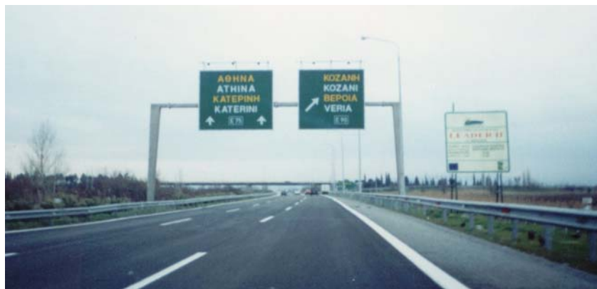
Εικόνα 11.4: ...Προ της εξόδου έχει τοποθετηθεί μία γέφυρα σήμανσης τύπου Π-85, ενώ μπροστά της βρίσκεται πινακίδα του ευρωπαϊκού προγράμματος “LEADER II”.
